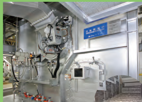
●焼却炉 炉内へ入ったごみは、ダイオキシン発生を抑制するため850℃以上の高温で焼却されます。
