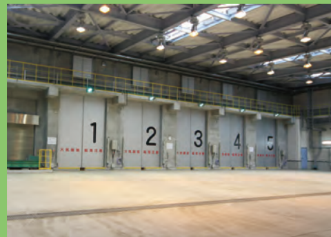
●プラットフォーム 計量を終えた収集車はこのプラットフォームに移動し、ごみをごみピットへ投入します。
